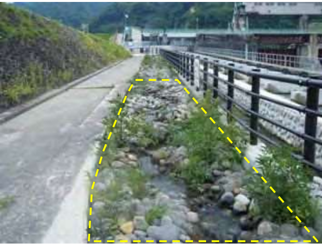
写真 2.2-2 (2) せせらぎ魚道内の調査区域 (S-3)
