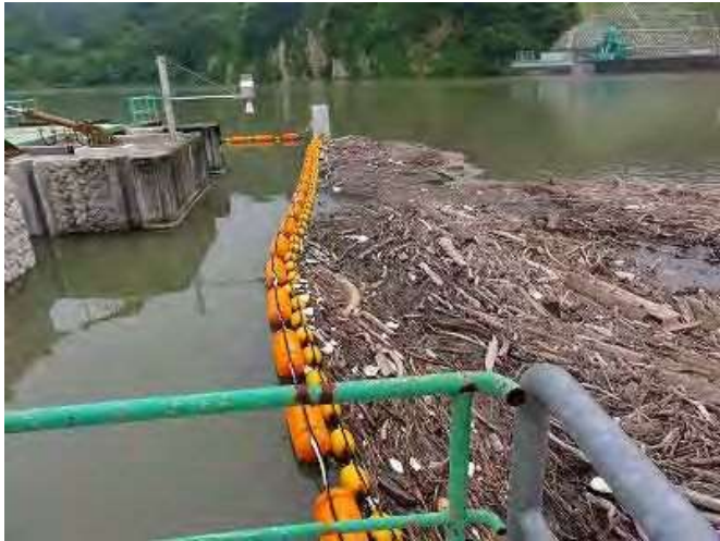
写真 1.2-2 網場によって流木・塵芥の魚道への流入が防がれている様子（平成24年6月25日撮影）
