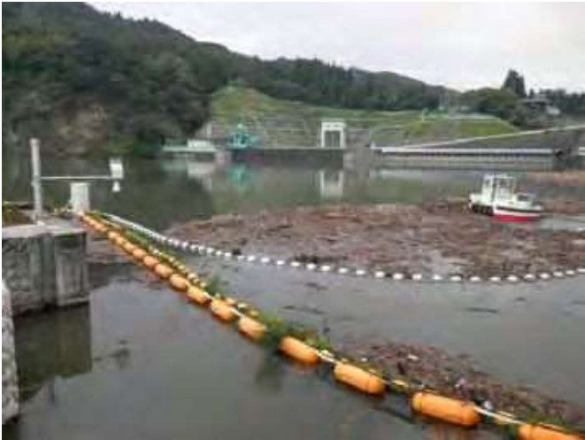
写真 1.2-3 作業船による流木・塵芥回収の様子
