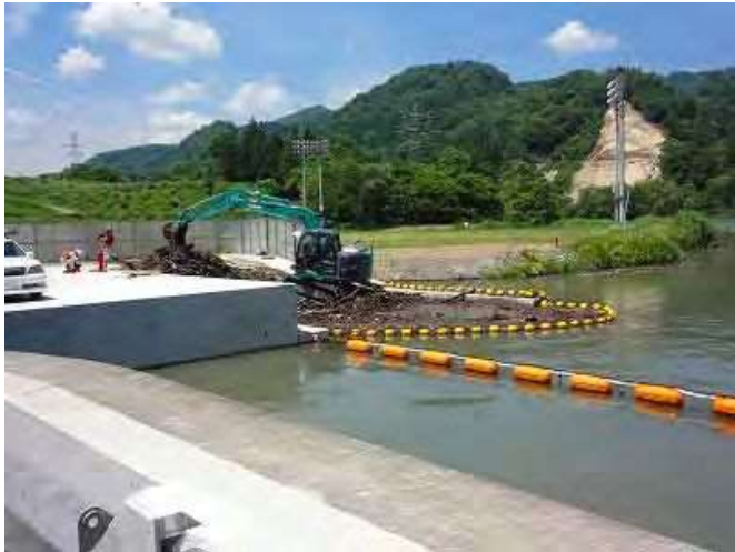
写真 1.2-4 重機による陸揚げの様子
