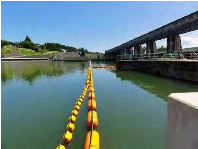
写真 1.2-1 網場の設置状況 （網を二重に設置している）
