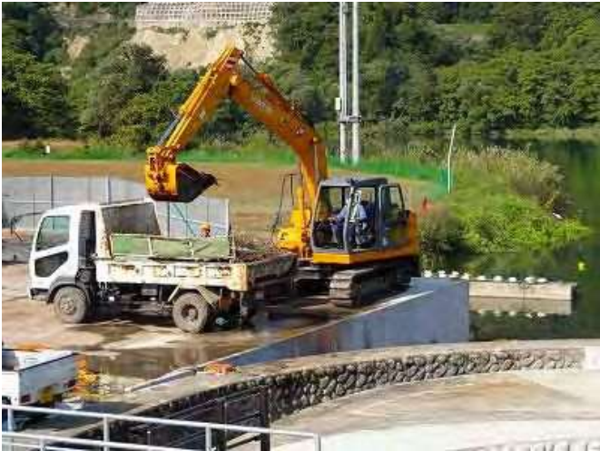
写真 1.2-5 ダンプトラックへの積み込みの様子
