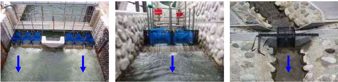
写真 2.1-1 捕獲カゴの設置の状況（左：大型魚道 中央：小型魚道 右：せせらぎ魚道）
