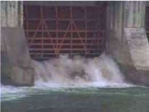
写真 3-3 フラッシング中
