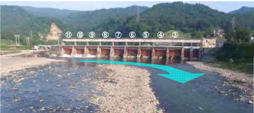
(平成 24 年 6 月 8 日の状況写真 パターン 1 に比較して、魚道入口付近の循環流の発生が抑制されている)
