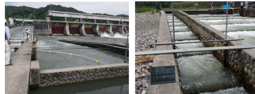
写真 1.2.1 下流仕切り網の設置状況（左：大型魚道、右：小型魚道）
