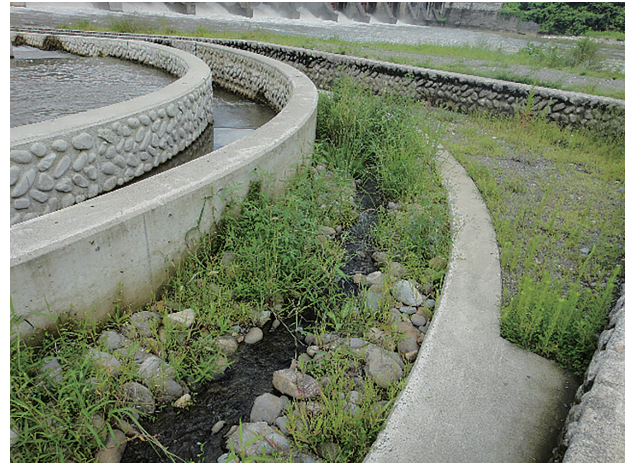
図 4. 調査時のせせらぎ魚道の植生状況。折り返し部や下流側は, 出水による土砂の堆積・流出が数年ごとに繰り返されている。
