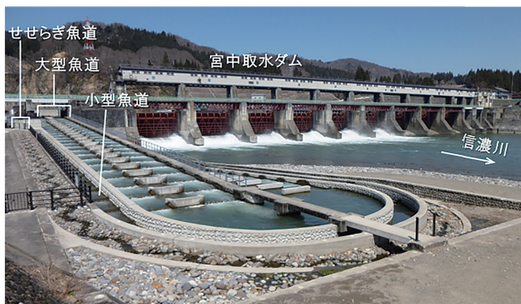
図1. 新設時のせせらぎ魚道（2012年3月）. 信濃川の宮中取水ダムに、魚道構造改善により“せせらぎ魚道”を新設.
