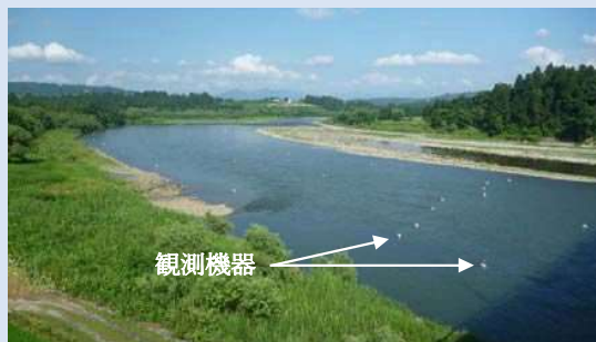
図一3 観測機器設置状況例(川井大橋地区)
