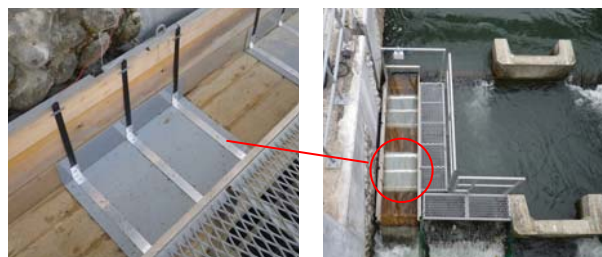
写真-1 仮設水路(右)と電極棒(左)
