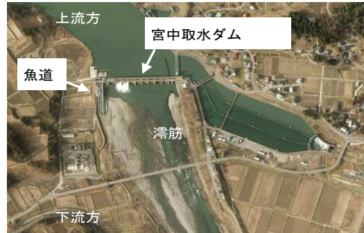
図-1 宮中取水ダム航空写真
