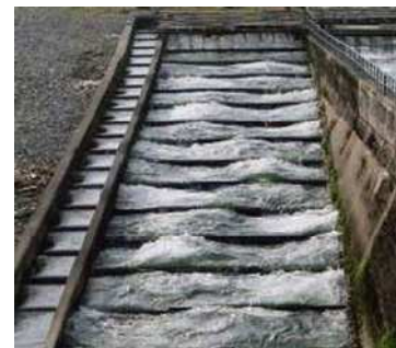
図-4 魚道改築前の大型魚道横波発生状況
