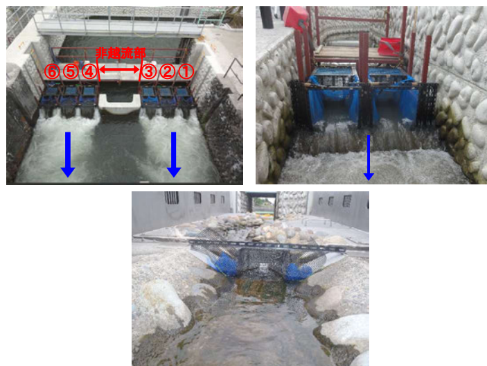
図-10 捕獲カゴの設置の状況 (左：大型魚道 右：小型魚道 下：せせらぎ魚道)
