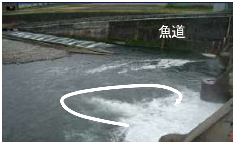
写真-2 魚道入口付近の循環流
