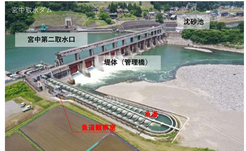
宮中取水ダム全景写真
