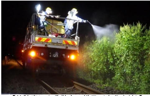
【軌陸車による散布の様子（東北本線）】
