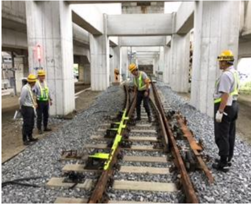
保守用車用の線路装置取扱訓練の様子 (保線)
