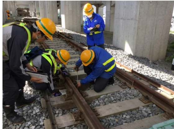
線路陥没発見時の対応訓練の様子 (土木)
