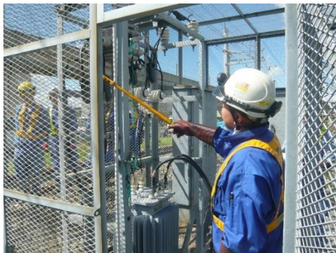
検電確認訓練の様子
