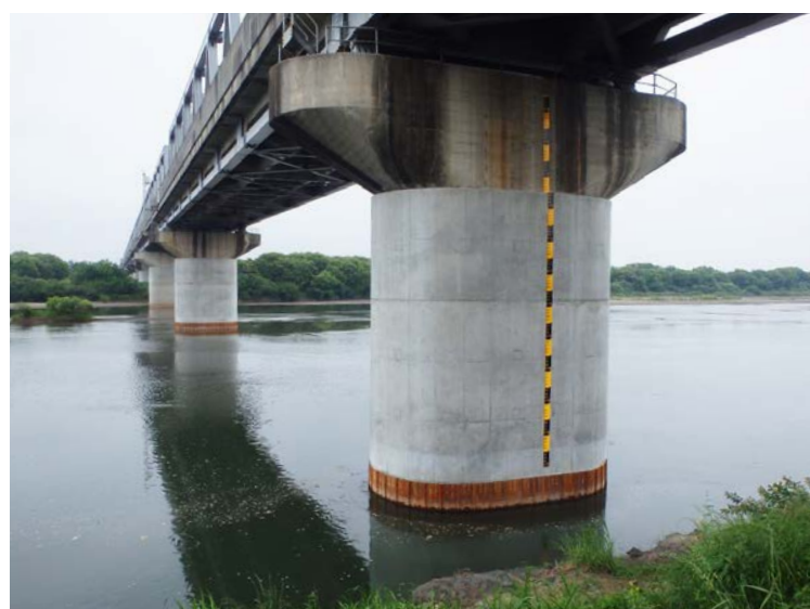
橋りょうの耐震対策
