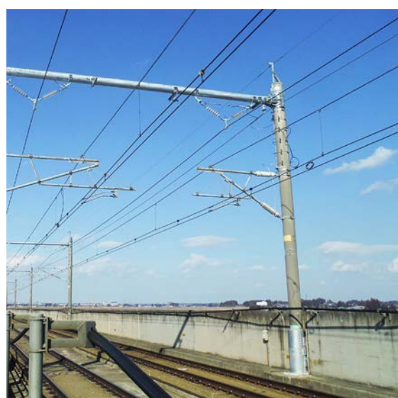
電架柱の耐震対策
