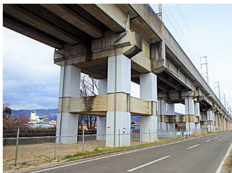
高架橋の耐震対策
