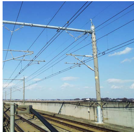
電架柱の耐震対策
