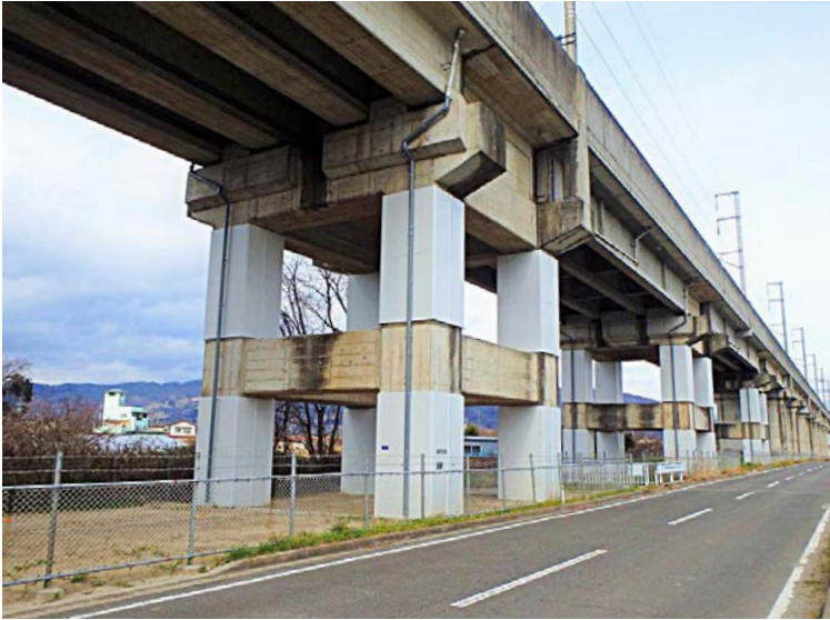
高架橋の耐震対策
