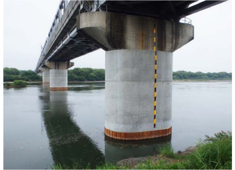
橋りょうの耐震対策
