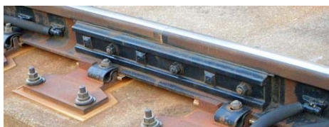
改良前の接着絶縁継目
