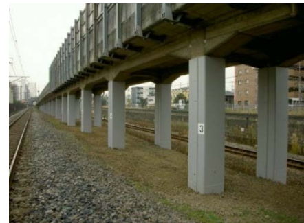
鋼板巻きによる高架橋柱の耐震補強
