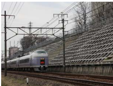
切取のり面工（吹付砕工）
