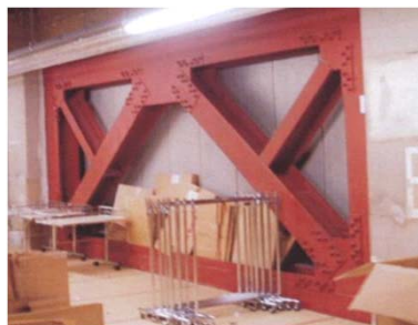
鉄骨ブレースによる補強
