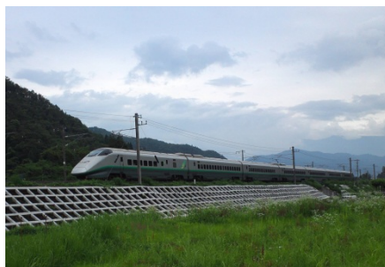
盛土のり面工（吹付砕工）
