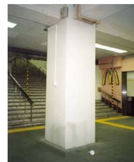
鋼板巻きによる柱の補強
