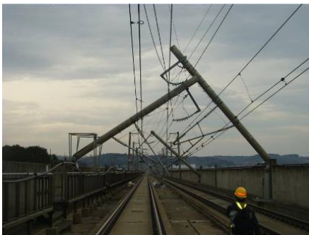
東日本大震災による電化柱の損傷例と補強イメージ
