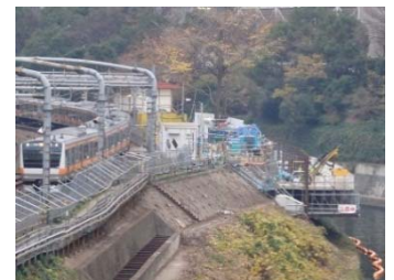
大規模地震対策(盛土の耐震補強)
