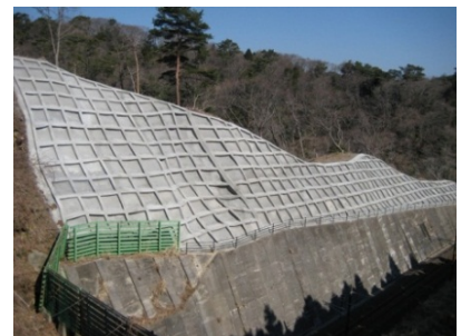
自然斜面防護工（吹付砕工）
