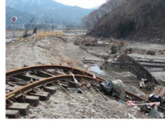
E【線路流失】 ほそつら (大船渡線 細浦構内)
