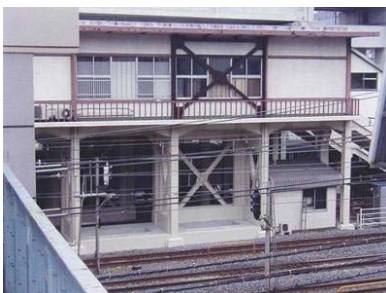
鉄骨ブレースによる補強
