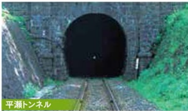
平瀬トンネル
