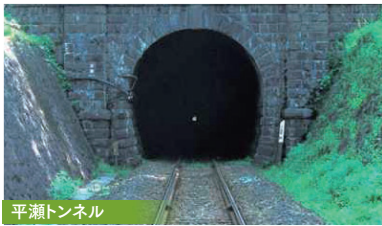
平瀬トンネル
