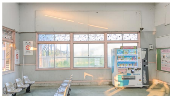
現待合室 (カフェスペース予定箇所)
