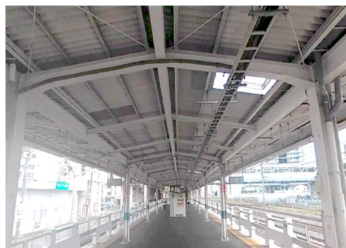
スレート製屋根（施工前）蕨駅
