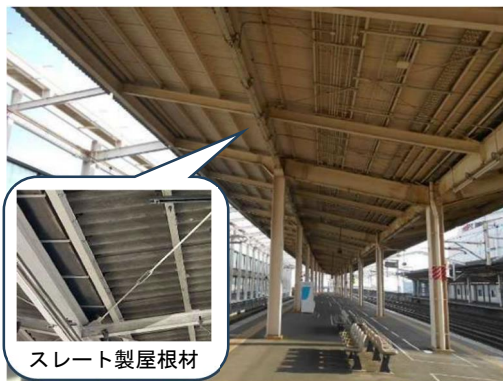
施工前（小山駅）
