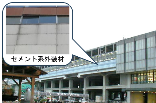
施工前（那須塩原駅）
