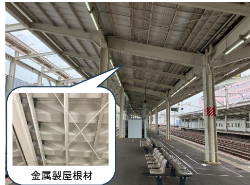
施工後（小山駅）
