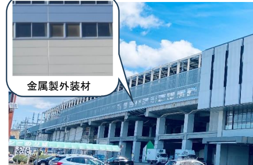
施工後（那須塩原駅）
