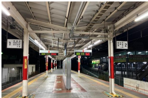
施工前（東川口駅）
