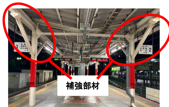
一部施工後（東川口駅）
