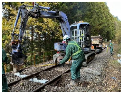
マクラギ交換（木製→コンクリート製）
