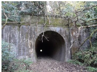
夕筋隧道 (撮影：2024 年 12 月)
