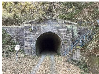
末続隧道 (撮影：2024 年 12 月)
