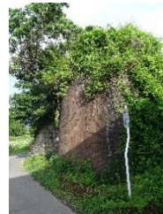
井出川橋梁橋台 (撮影：2024 年 12 月)
