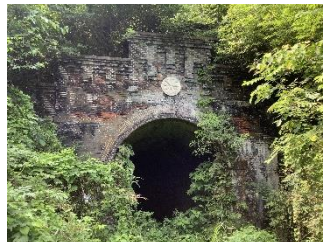
金山隧道 (撮影：2025 年 7 月)
