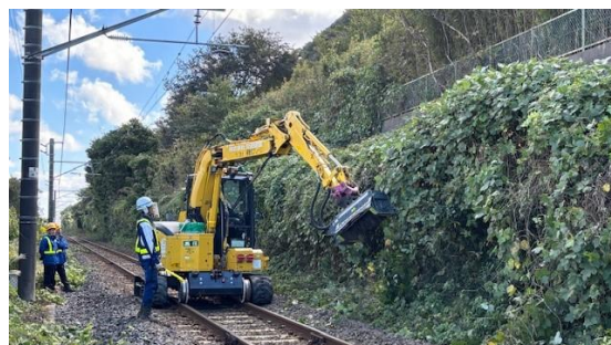
支障樹木の伐採
