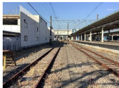
君津駅構内電留線
