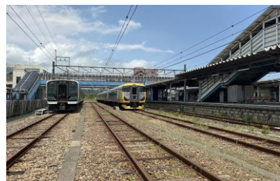
安房鴨川駅電留線
