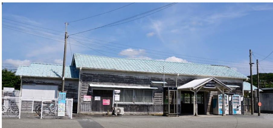
那古船形駅舎外観
