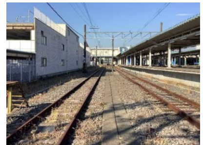
君津駅構内電留線
