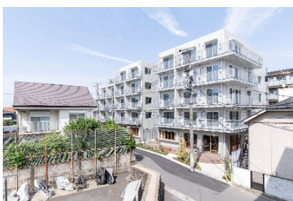
【集合住宅 高円寺アパートメント】
