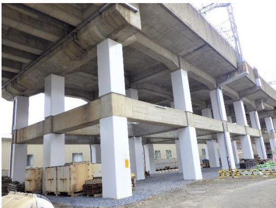
高架橋柱（鋼板巻立て）
