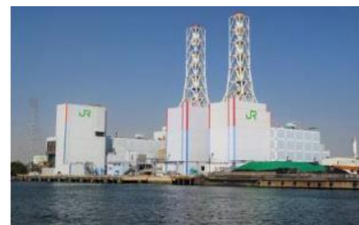
川崎火力発電所
