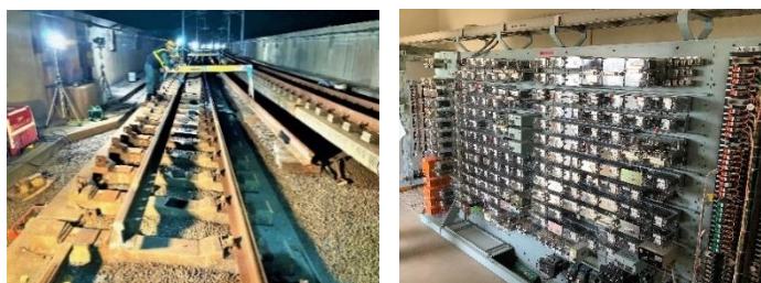
特に力を入れる修繕内容 (左図：レール交換 右図：信号リレー取替)
