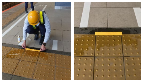
雨天時を想定した点字ブロック修繕作業
