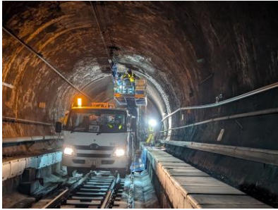
【漏水剥落修繕】
