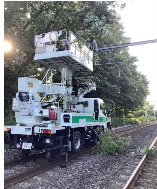
伐採・撤去作業
