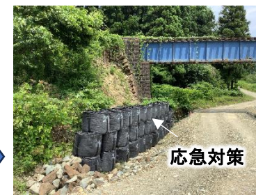
応急対策後（2025 年 6 月撮影）
