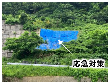
応急対策後（2025 年 7 月撮影）
