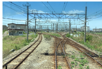
川越車両センター構内
