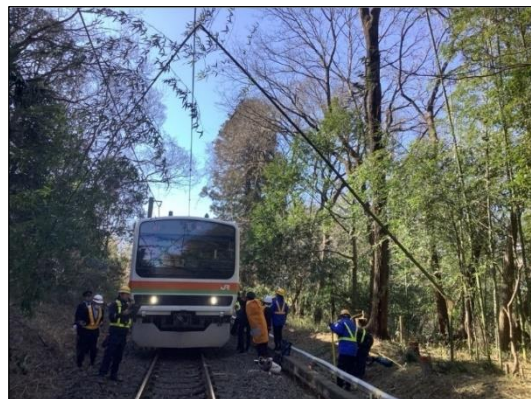
川越線倒木発生状況
