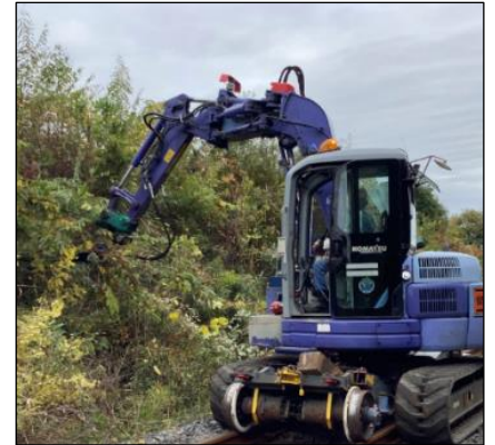
重機による伐採
