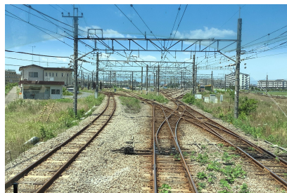
川越車両センター構内
