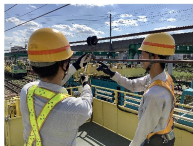
電力設備の保守作業体験
