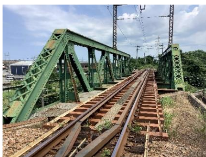
白新線を越す貨物支線の鉄橋
