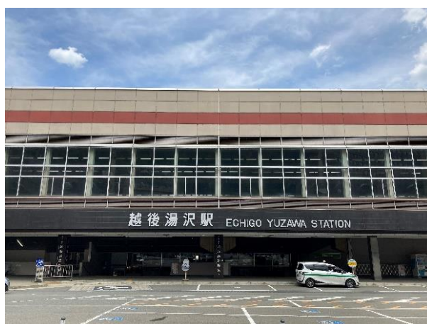
越後湯沢駅 駅舎
