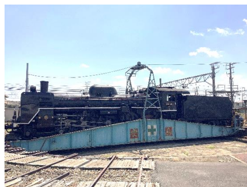
転車台 撮影エリアからの撮影イメージ
