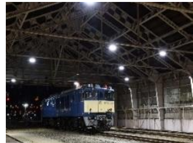
庫内照明（夜間）
