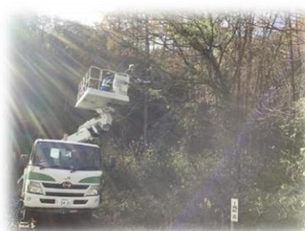
樹木伐採作業
