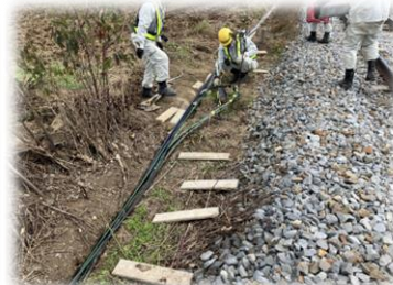
鉄道ケーブル修繕
