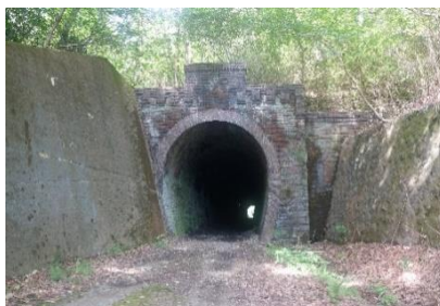
第一耳ヶ谷隧道
