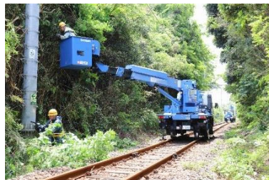
支障樹木の伐採
