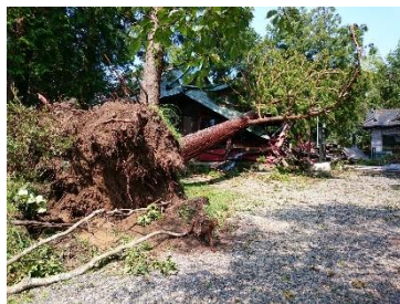
久留里神社拝殿（倒壊直後）
