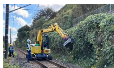
支障樹木の伐採
