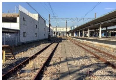
君津駅構内電留線
