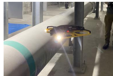
ドローンを活用した設備点検
