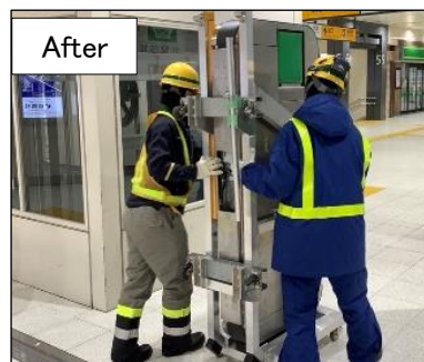
エレベーターを活用した運搬
