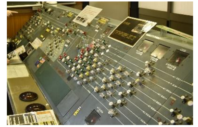
旧第1種継電連動装置表示盤
